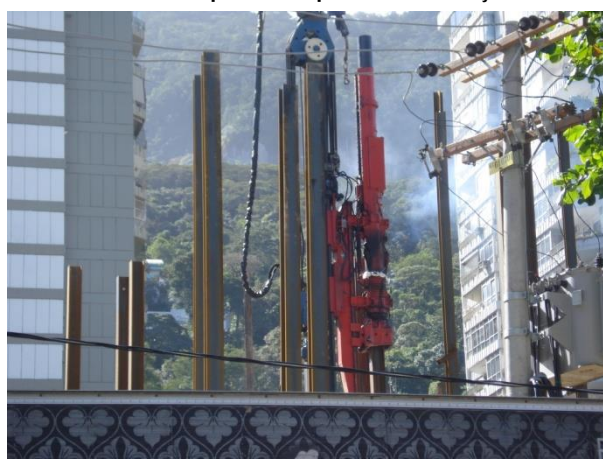
Figura 5 - Vista do bate estacas analisado a partir do ponto de medição 5
