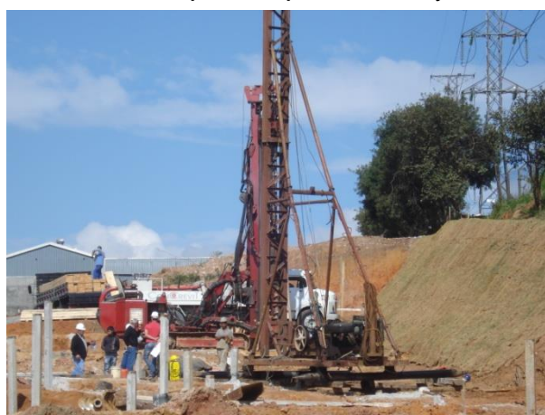
Figura 4 - Vista do bate estacas analisado a partir do ponto de medição 4
