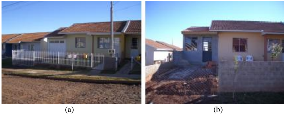
Figura 3 - Empreendimento Nova Aurora, na cidade de Chapecó: (a) criação de garagem e gradil; e (b) construção de unidade para aluguel e muro Fonte: Digiacom (2004).
