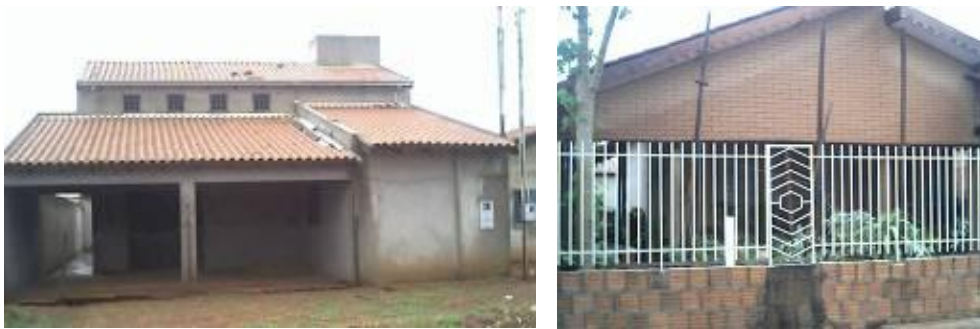
Figura 7 - Casas construídas, originalmente, com tijolos de solo-cimento, com área inicial em torno de 42 m 2 - a casa à esquerda foi totalmente descaracterizada em relação ao projeto original
