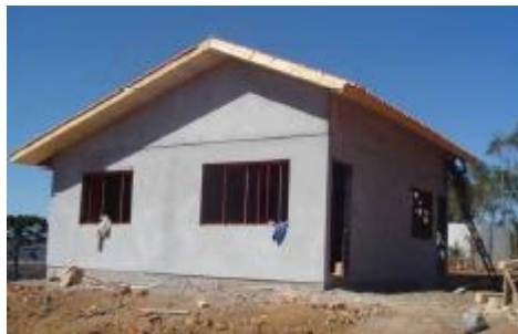
Figura 17 - Casa em fase de construção em Videira, Santa Catarina: o telhado original foi modificado a pedido dos proprietários com a intenção de ampliação futura Fonte: Digiacom (2004).
