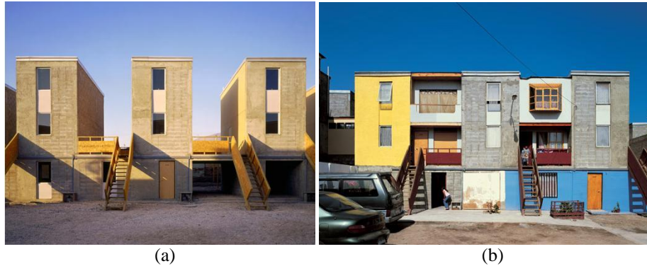
Figura 16 - Conjunto residencial Quinta Monroy, Iquique, Chile: (a) fachada original, sem intervenções; e (b) fachada já ocupadas, com intervenções dos moradores
