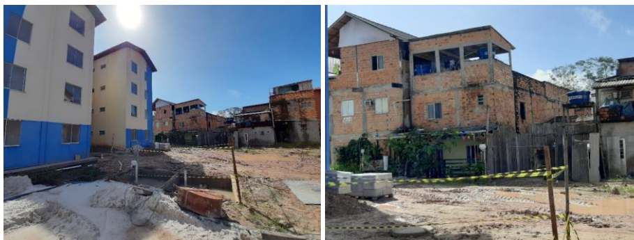
Figura 11 - Isolamento da obra
