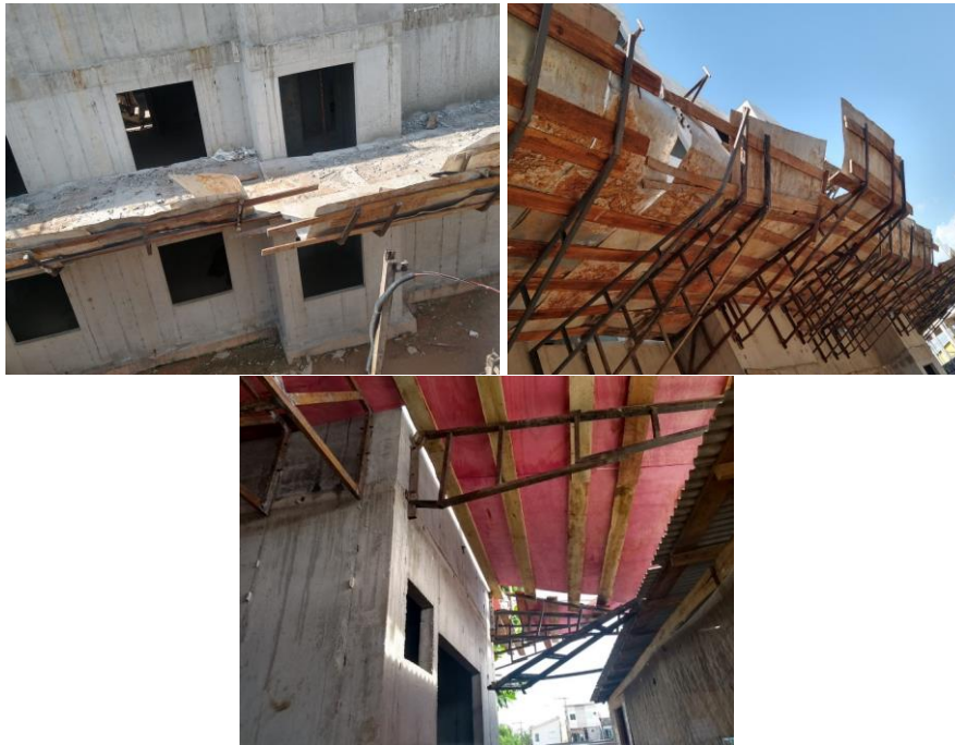
Figura 10 - Cenário real das bandejas de proteção encontradas na obra
