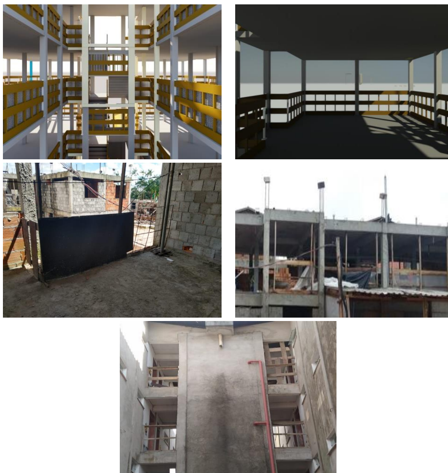
Figura 7 - Comparação da modelagem e o cenário dos guarda-corpos
