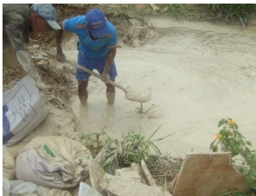
Figura 1 - Detalhamento da retirada do RSPC do tanque de decantação
