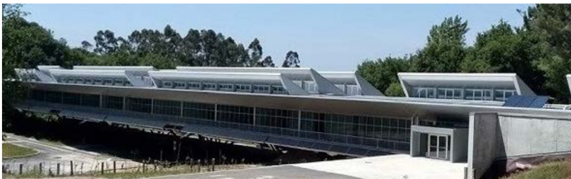
Figura 2 - Vista da fachada sul do edifício
