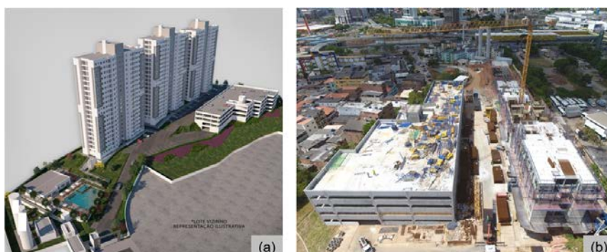
Figura 2 - Obra A: (a) Projeto do empreendimento; e (b) Canteiro no dia 05/04/2021
