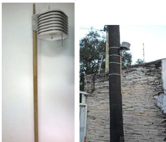
Figura 4 - Instrumentação instalada e detalhe da proteção
