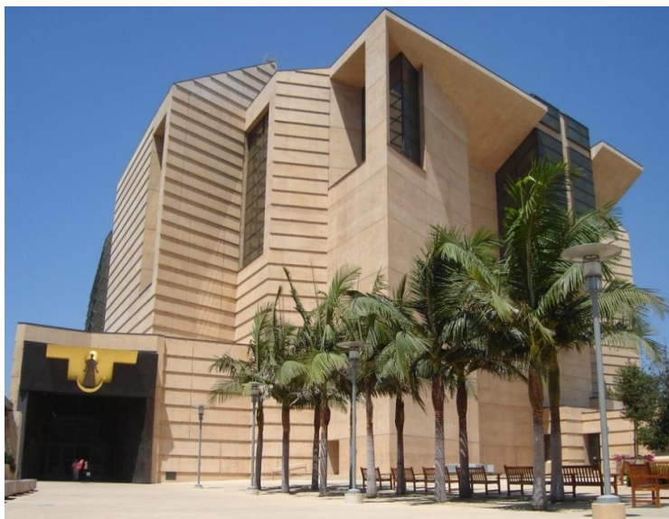
(a) Vista geral da obra
