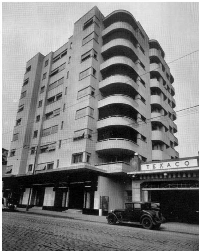
Figura 29 – Vista geral do Edifício Columbus, rua Brigadeiro Luís Antônio, projetado por Rino Levi. (RINO LEVI, 1974, p. 31).
