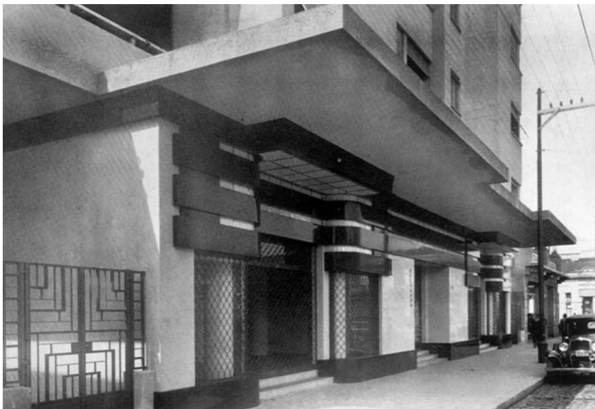
Figura 32 – Tratamento do piso térreo do Edifício Columbus, com revestimento em pedra e detalhamento Art déco (RINO LEVI, 1974, p. 32).
