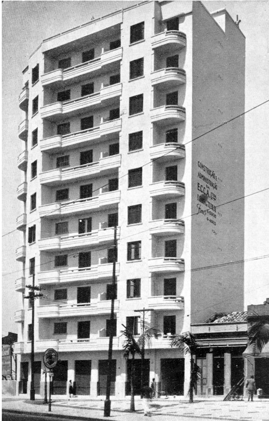
Figura 6 – Fachada principal do Prédio Zena, rua Frederico Abranches com rua Sebastião Pereira, projetado pela Empresa Construtora Concreto Armado Ltda. (ACRÓPOLE, mar. 1940, p. 34).
