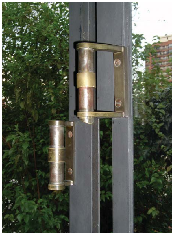
Figura 31 – Detalhe de fecho de janela de correr projetado por Rino Levi, muitíssimo usual nas décadas de 1930 e 1940, inclusive em obras de outros arquitetos. Residência da autora. Fotografia de Maria Lucia Bressan Pinheiro, 2007.
