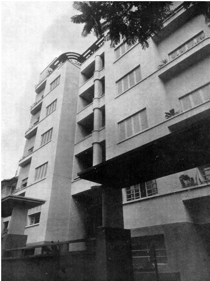
Figura 33 – Fachada principal do Prédio Higienópolis, rua Conselheiro Brotero, projetado por Rino Levi (ACRÓPOLE, jul. 1940, p. 107).
