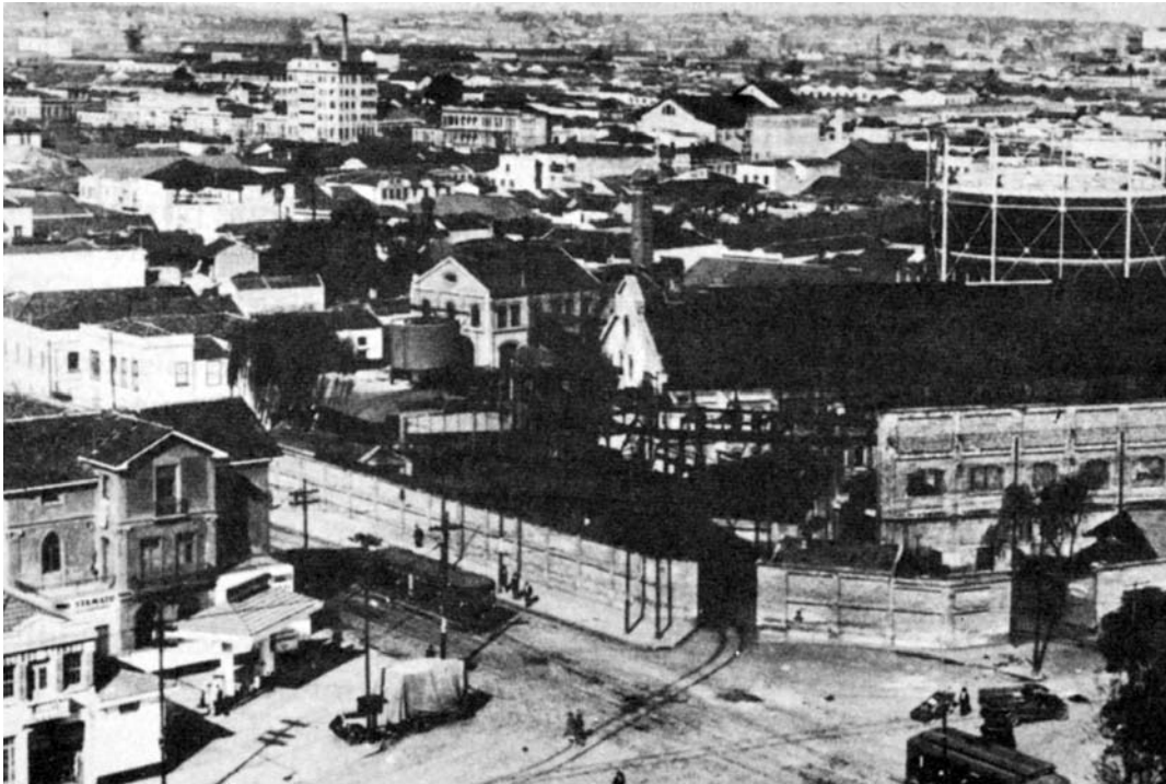
Figura 20 – Anônimo. Aspecto do Gasômetro, no Brás. À extrema esquerda da imagem, chalé usado como sede da clínica do dr. Carlos Botelho, 1932. Fotografia. Em Geraldo Sesso Jr. (1983).
