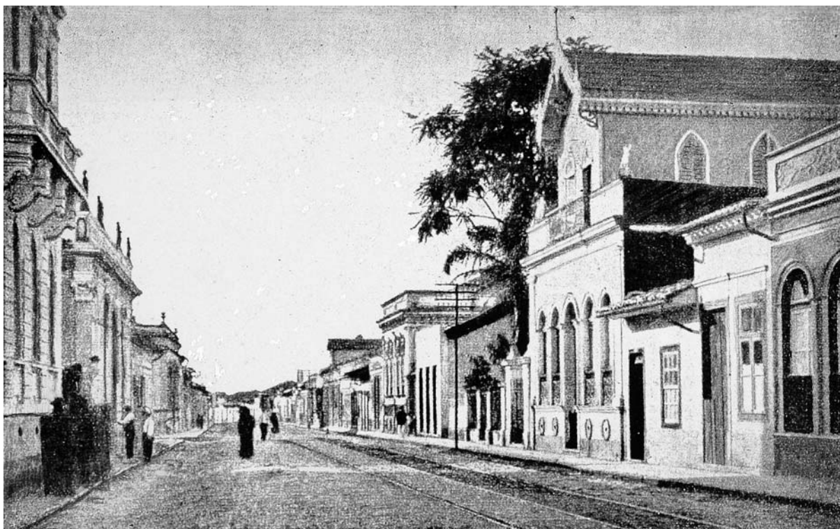
Figura 26 – Na vista da rua Sete de Abril, surpreendemos uma bela edificação que combinava elementos neoclássicos presentes no primeiro pavimento com um mirante achalezado de aparência neogótica na cobertura. Um tipo de construção, ao que parece, influenciado pela “casa com torre” açoriana. Axel Frick. Aspecto da rua Sete de Abril, c. 1895. Fotografia. Em Gustavo Koenigswald (1895). Acervo Biblioteca Mário de Andrade, São Paulo. Reprodução de José Rosael.
