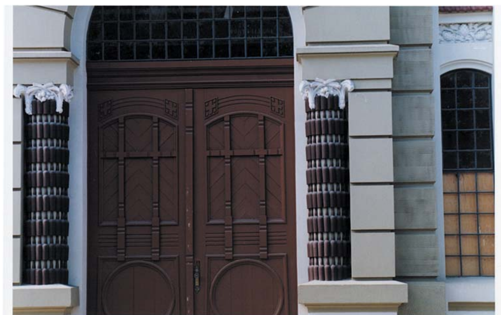
Figura 7 – Colunas na forma de garrafas empilhadas na entrada do Prédio 1, fotografia de Lúcio Lorde.
