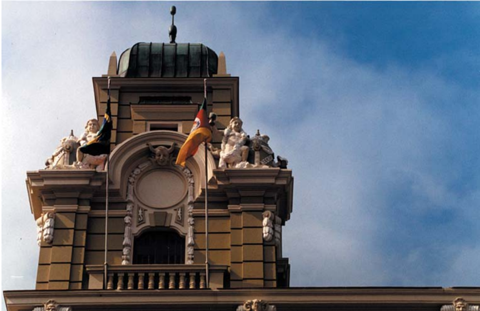
Figura 12 – Torre do Prédio 2, fotografia de Lúcio Lorde.
