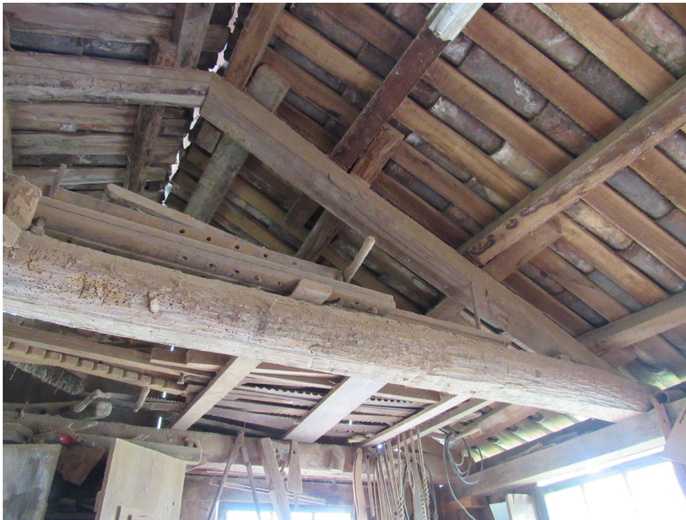
Figura 22 – Detalhe do telhado da marcenaria, 2017. Fotografia do autor.
