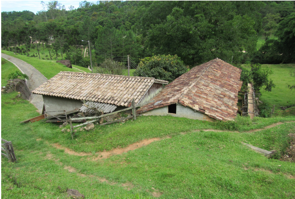
Figura 17 – Edifício da marcenaria, detalhe do telhado, 2017. Fotografia do autor.
