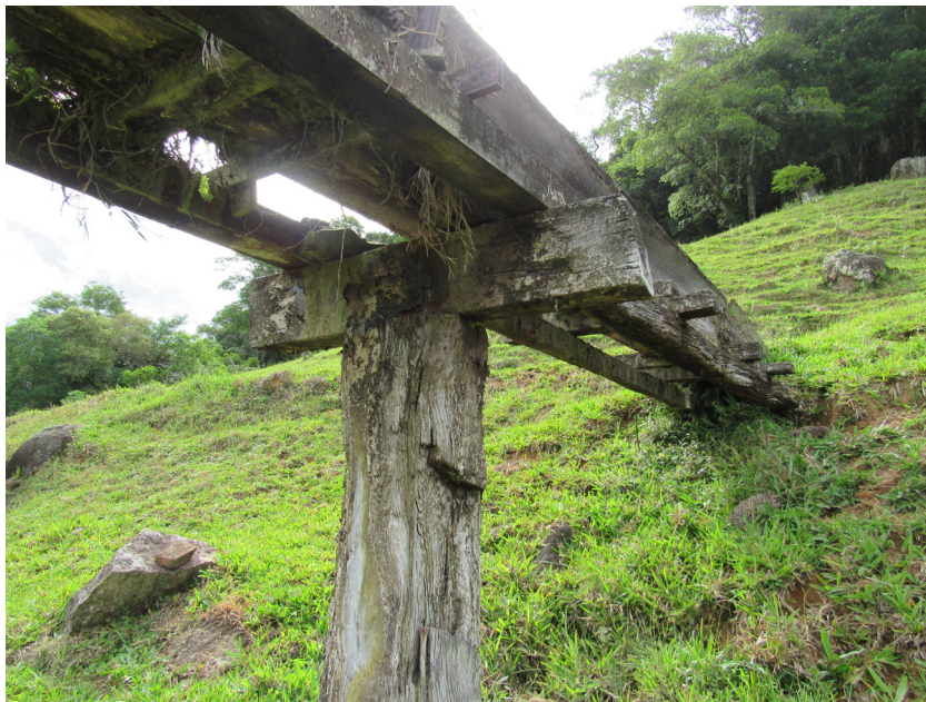
Figura 2 – Detalhe da calha de madeira, 2017. Fotografia do autor.
