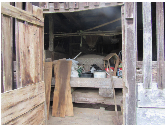
Figuras 12 e 13 – Detalhes da edificação da atafona, 2017. Fotografia do autor.
