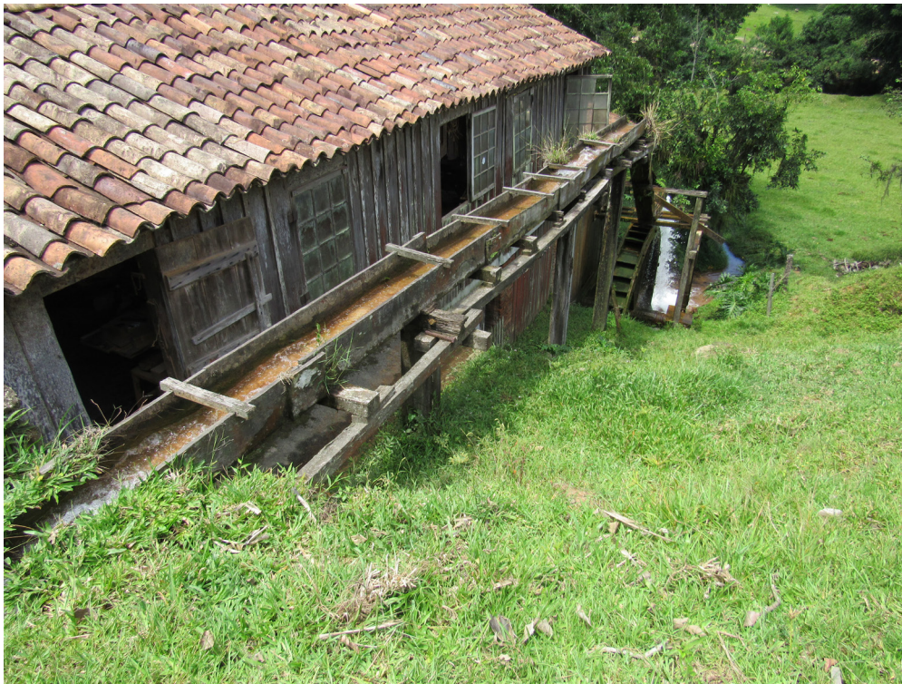
Figura 19 – Parte lateral do edifício da marcenaria, 2017. Fotografia do autor.
