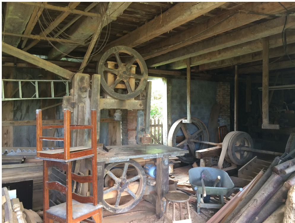
Figura 21 – Detalhe dos barrotes da área onde funcionava a serraria, 2017. Fotografia do autor.
