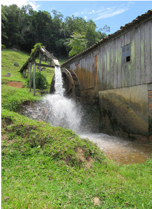
Figuras 6, 7 e 8 – Detalhe da roda-d'água da atafona, 2017. Fotografia do autor
