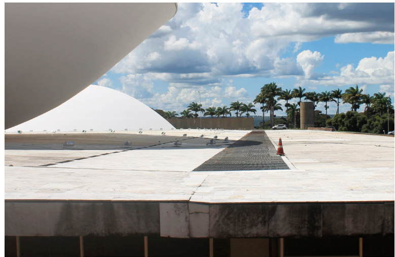
Figura 4b – À esquerda, trecho inicial, com cobertura mais inclinada. Ao centro, grelha do jardim. À direita, ampliação de 1968. Emenda visível na borda da cobertura. Fonte: fotografia do autor, 2022.
