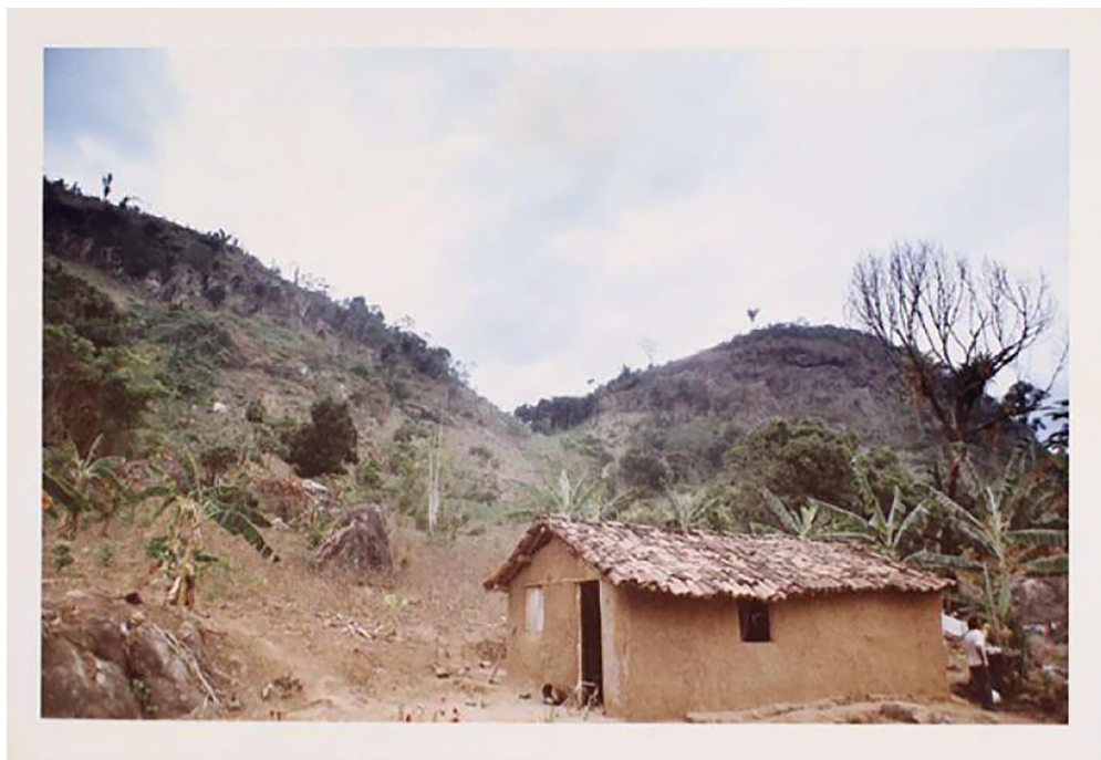
Figura 4 – Fotografia publicada no processo de tombamento, na qual pode ser vista uma edificação popular construída na Serra da Barriga. Fonte: Instituto do Patrimônio Histórico e Artístico Nacional (1986b)
