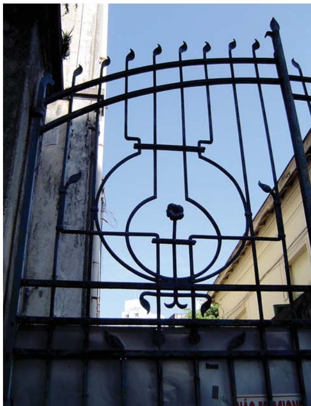
Figura 17 – Residência na Rua Bueno de Andrade, São Paulo. Fotografia de Paulo César Garcez Marins, 2008.
