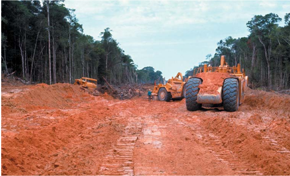
Figura 38 – Transamazônica: desmatamento e construção da estrada, 1972. Fotografia de Pierre Monbeig. Copyright PRODIG/ CNRS, Paris.
