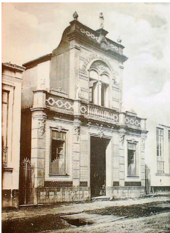
Figuras 52 e 53 – Exemplar da fachada descaracterizada de um antigo estabelecimento de vendas de materiais de construção, “Salvador, Mesquita & C o Constructores”, localizado na Travessa São Francisco, n o 10, em Belém do Pará. Na primeira imagem, vê-se o imóvel no ano de 1910 e a segunda fotografia data de 2016, em que se nota a descaracterização do imóvel. Referente aos ornamentos, observa-se o desaparecimento da estátua, que adornava o centro da platibanda, das duas pinhas que ornavam as pontas e de quatro estátuas, que se situavam na altura do balcão, na direção da marcação de quatro colunas. Fonte: Indicador Ilustrado do Estado do Pará - Parte II (1910). Na página ao lado, fotografia de Tainá Arruda, 2015.
