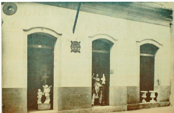
Figuras 9, 10 e 11: Fotos de lojas de materiais de construção que comercializavam ornamentos cerâmicos vitrificados em Belém: Grandes oficinas mechanicas da "Marmoaria Luzitana", rua Padre Prudencio nº13 e 15 com succursal em frente ao Cemiterio de Santa Izabel; Loja Salvador Mesquita, localizada na Travesa São Francisco; fachada externa da loja Marmoaria Luzitana. Fonte: Indicador Illustrado do Estado do Pará - Parte II (1910).
