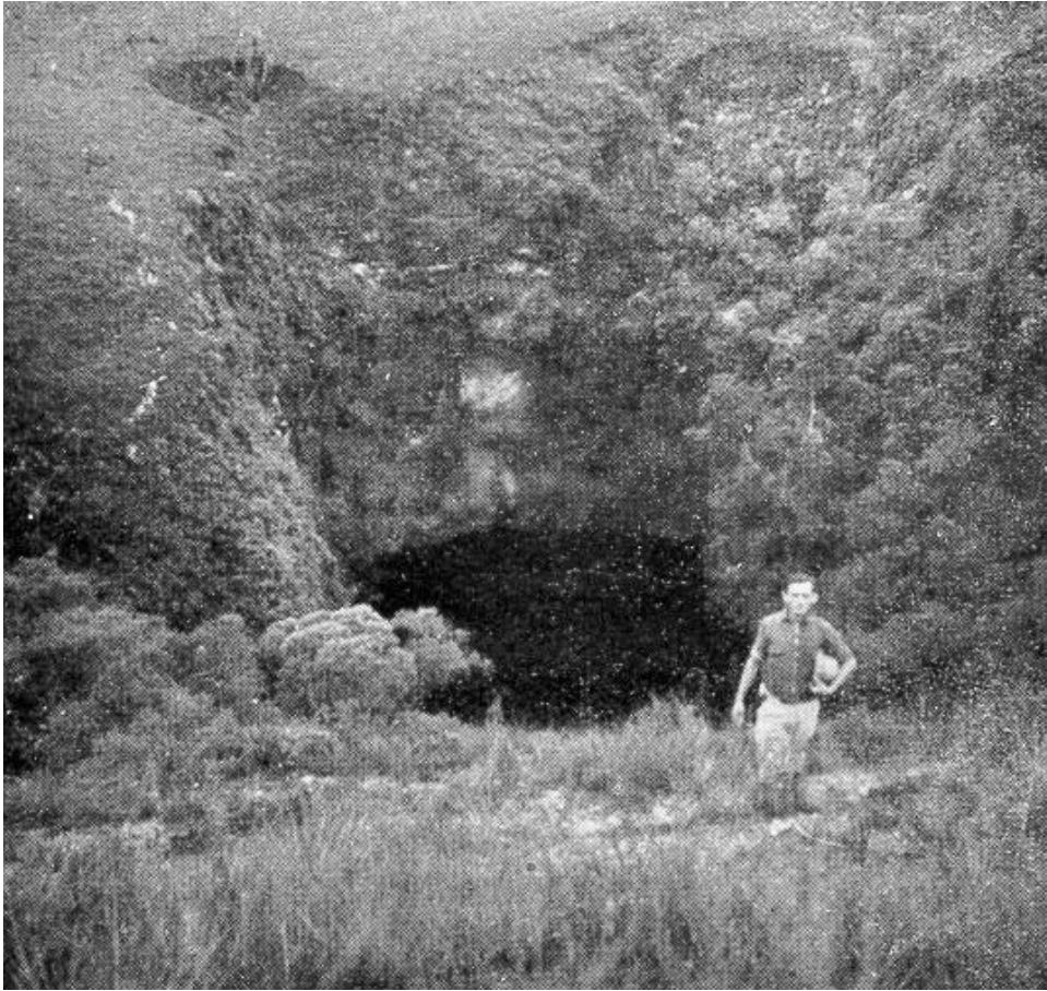
Fig 27 – Poço de desabamento (poço nº 2) proveniente de erosão subterrânea e decomposição por infiltração no arenito das Furnas na fazenda Lagoa Dourada.
