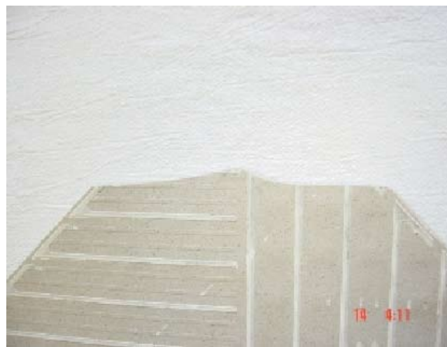
Figura 4: Detalhe da vista lateral da estrutura metálica portante das placas cerâmicas.
