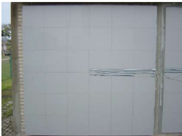
Figura 3: Modo de inserção dos parafusos expansores nos furos das placas cerâmicas.
