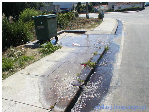
Figura 3. Desperdício de água
