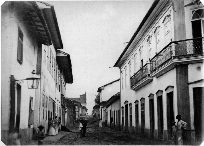
Figura 2. Plano médio a partir do rés-do-chão sobre rua que atualmente integra a Praça da Sé (c. 1862)
