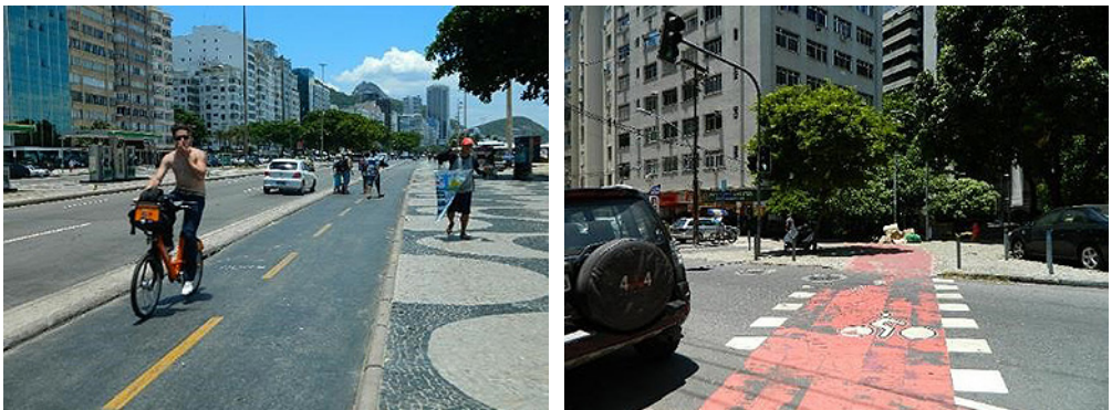
Figura 5 – Condições do piso das ciclovias/ciclofaixas no bairro de Copacabana
