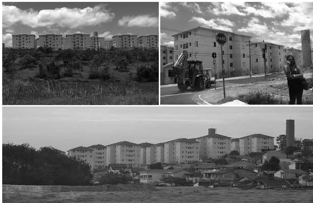
Foto 1 – Empreendimentos contíguos Peruíbe e Praia Grande na cidade de Hortolândia, Região Metropolitana de Campinas. Somados, possuem 500 unidades habitacionais
