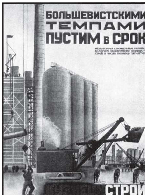
Construção de Kuznetsk: em ritmo bolchevique, por K Vialov, 1931
