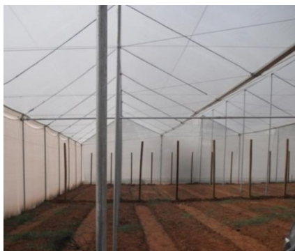
FIGURA 1: Vista interna das estruturas (Rio das Pedras-SP, 2011). Internal view of the structures.
