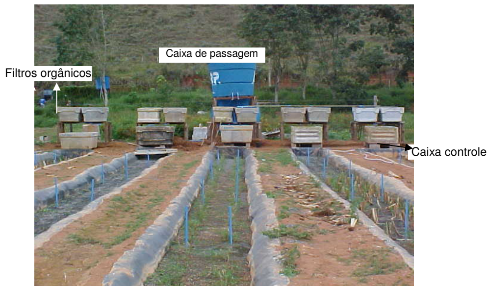
FIGURA 2. Vista parcial da montagem dos sistemas alagados e do sistema de aplicação da água residuária. Partial view of the constructed wetlands and systems of wastewater application.
