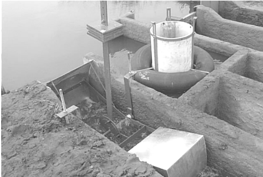
FIGURA 3. Protótipos instalados junto à estrutura de alvenaria.
