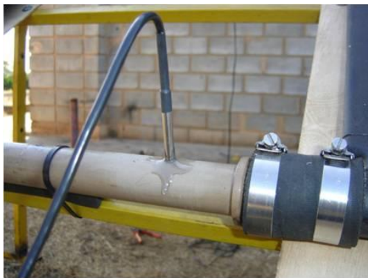
FIGURA 3. Sensores de temperatura do tipo PT-100 inseridos nas tubulações. PT-100 temperature sensors inserted in the pipes.
