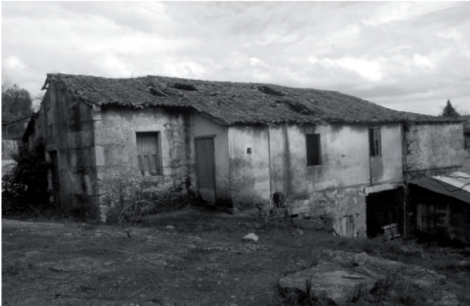
Figura 11: Casa do Forno (Rendufinho, Póvoa de Lanhoso). Fachada principal
