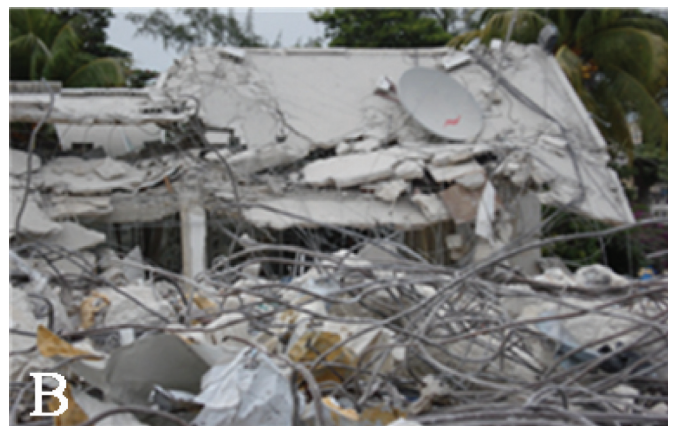
Figura 1. A. Visão aérea da destruição de um conjunto popular habitacional após o terremoto. B. Exemplo de destruição de uma construção após o terremoto
