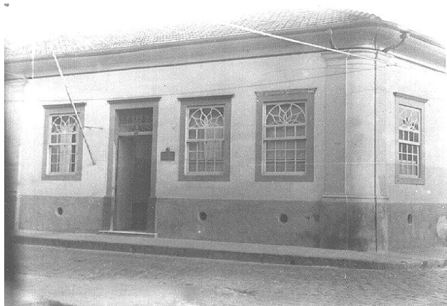
FIGURA 3-FACHADA DO EDIFÍCIO DO 3º GRUPO ESCOLAR DE CAMPINAS, GE ARTUR SEGURADO, DÉCADA DE 1930.
