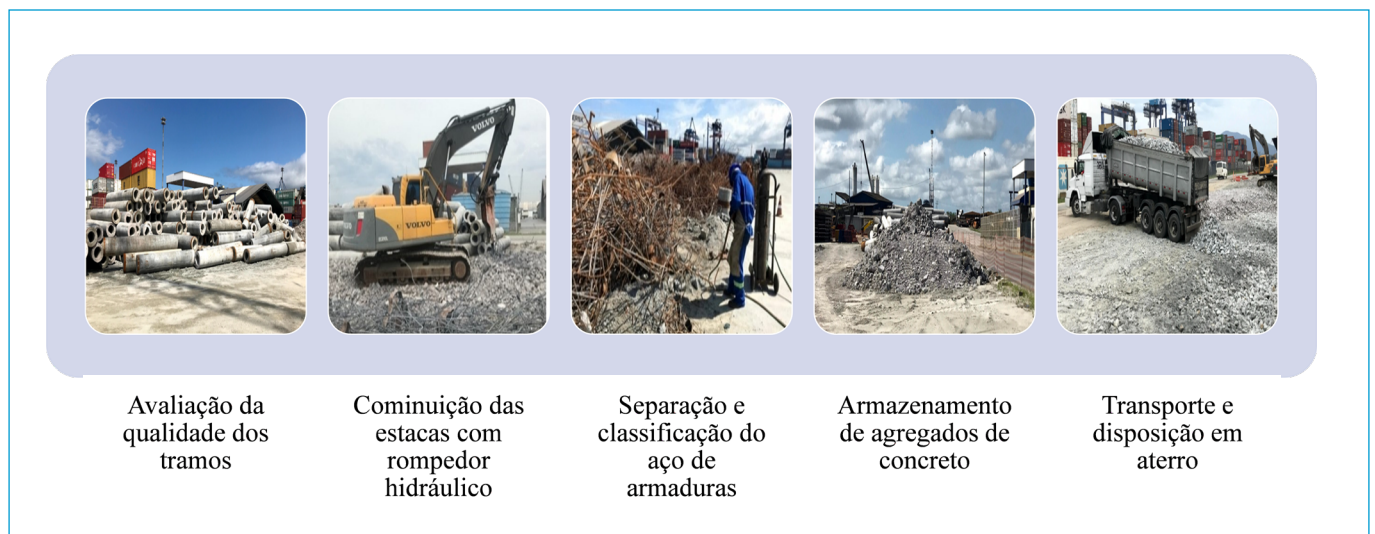
Figura 5 - Processo de aproveitamento das estacas de concreto, incluindo sua classificação, beneficiamento e disposição em aterro na própria obra.
