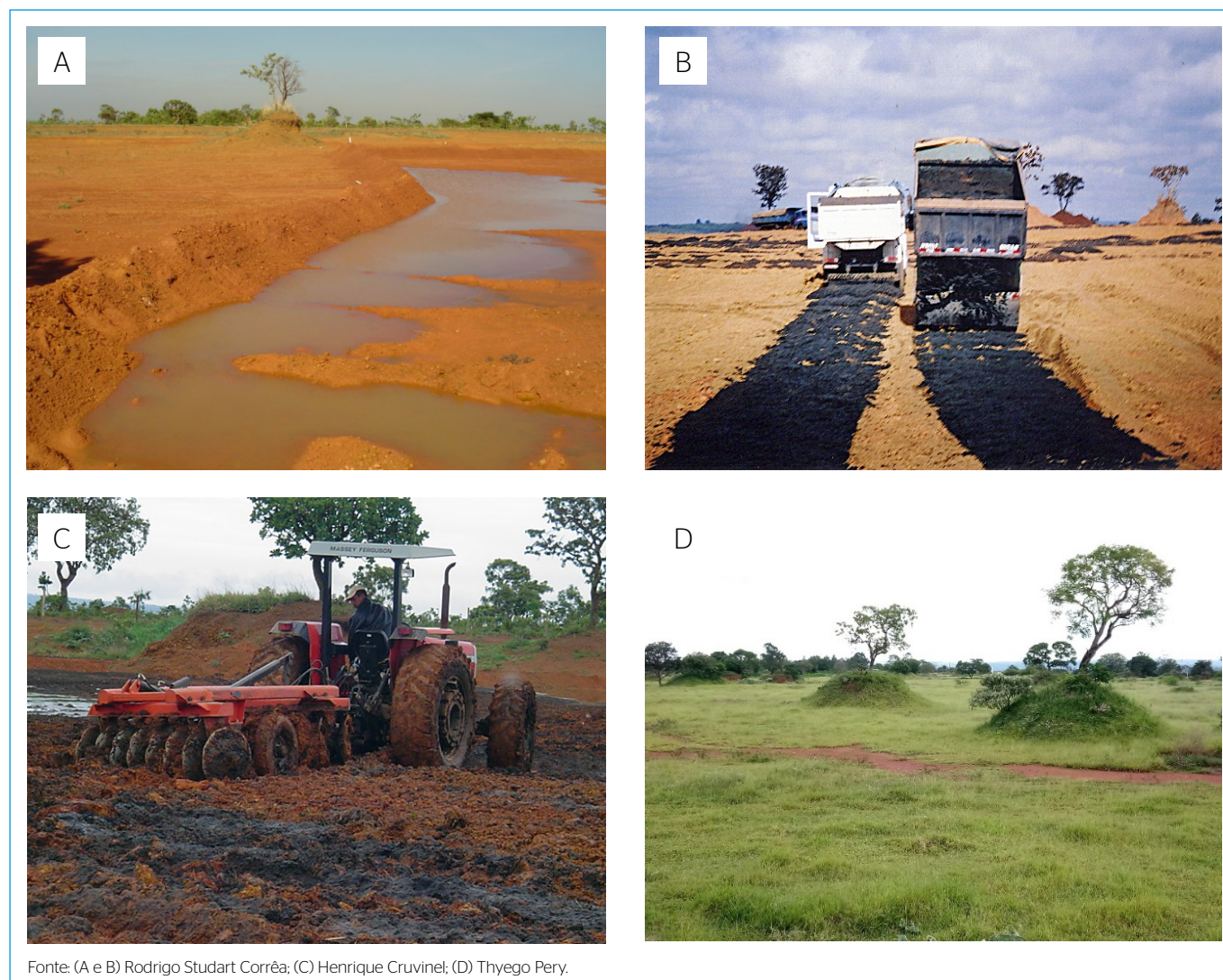
Figura 2 – (A) Substrato minerado após a exploração de cascalho; (B) deposição de lodo de esgoto por caminhões sobre o substrato minerado; (C) incorporação do lodo de esgoto ao substrato minerado; (D) área revegetada 16 anos após a aplicação de lodo de estações de tratamento de esgoto.
