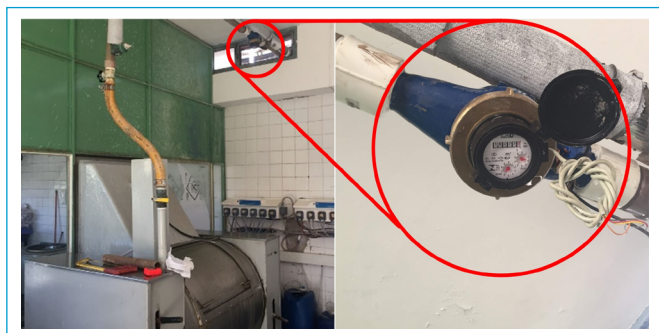
Figura 5 - Instalação de hidrômetro na tubulação que distribui água para a lavanderia.
