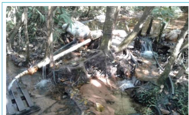
Figura 11 - Condições locais relativas à captação superficial em São Carlos (nov. 2019).
