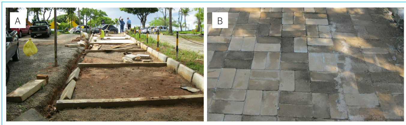
Figura 2 - (A) Processo de colocação dos meios-fios e das vigas transversais e assentamento dos blocos na camada de areia; (B) detalhe da trama do intertravamento.
