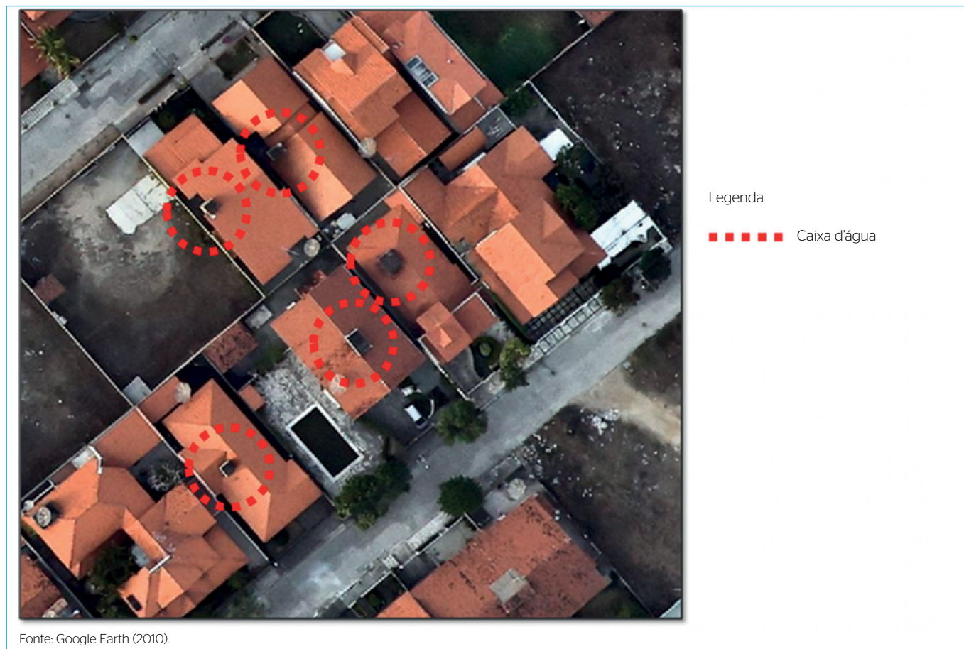
Figura 6 - Caixas d'água nas edificações.
