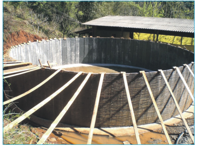
Figura 5 - Escoramento da parede.
