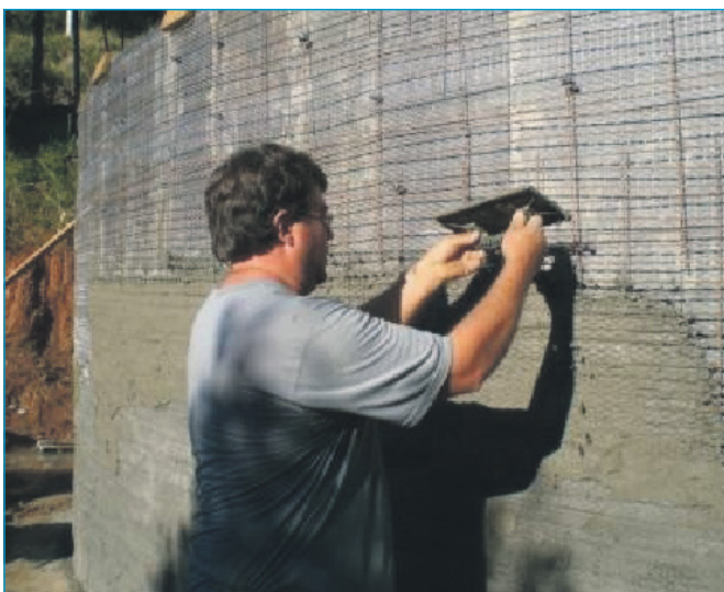
Figura 4 - Armadura e argamassagem.
