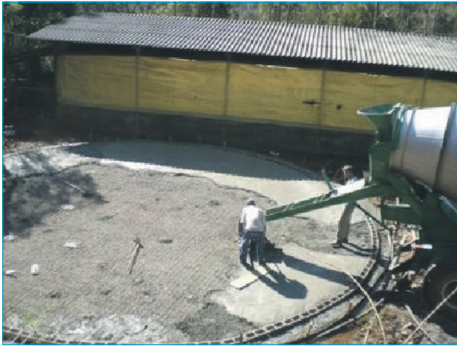
Figura 2 - Execução da base do reservatório.
