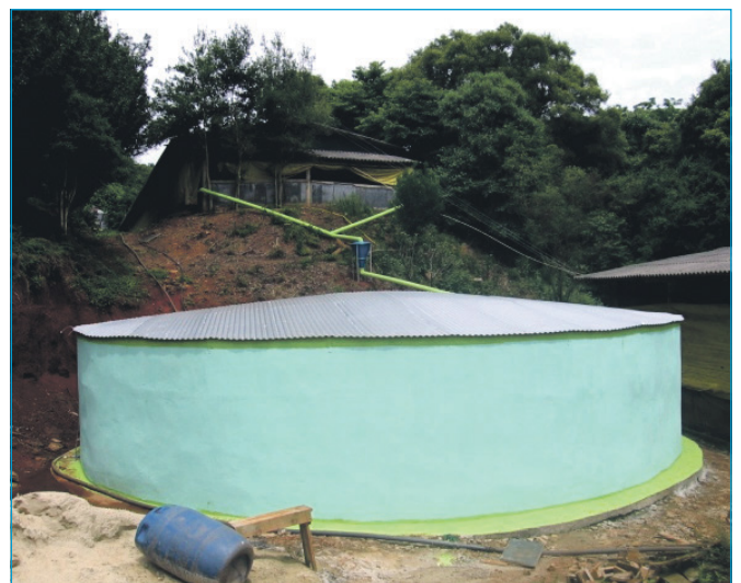
Figura 7 - Vista geral do reservatório de 250 m 3 .
