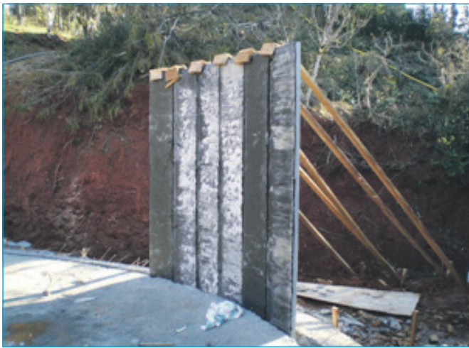
Figura 3 - Montagem das placas de ardósia.
