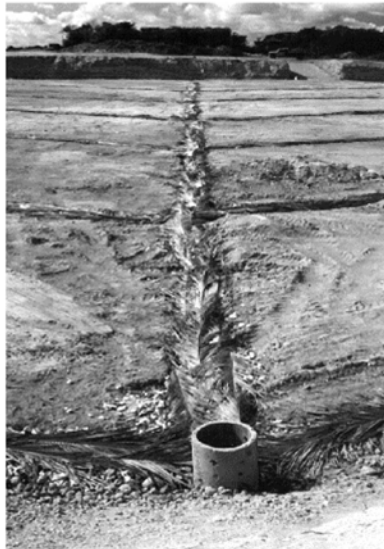
Figura 1 - Drenagem de líquidos percolados do tipo "espinha de peixe" no fundo de uma trincheira do ASMOC - Ceará
