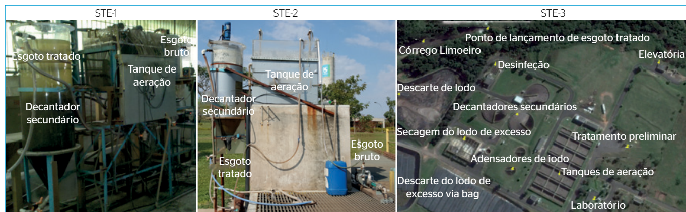
Figura 1 - Sistemas de lodos ativados com aeração prolongada avaliados durante o estudo. STE-1 e STE-2 em escala piloto e STE-3 em escala real.
