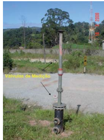
Figura 2 – Foto da chaminé instalada em cima do poço de biogás para o estudo de poços com exaustão passiva
