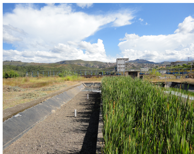
Figura 1 - Vista das unidades do sistema de alagados construídos, não plantada e plantada.
