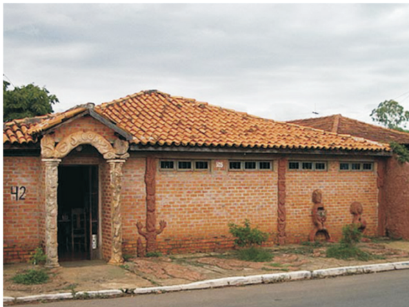
Fig. 12. Casa Basaia – Fachada.
