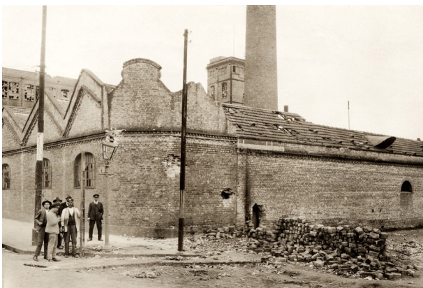
Fig. 1. A. de Barros Lobo, Fábrica Crespi após bombardeios , Mooca, São Paulo, 1924. Fonte: Acervo Instituto Moreira Salles, São Paulo, 2015.
