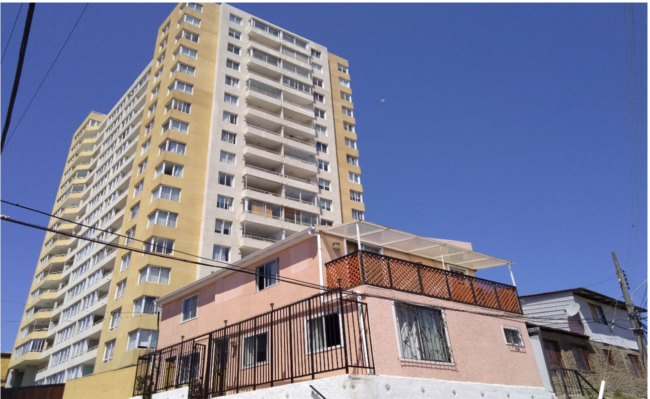
Figura 5 – Nuevo edificio en el cerro Barón.
