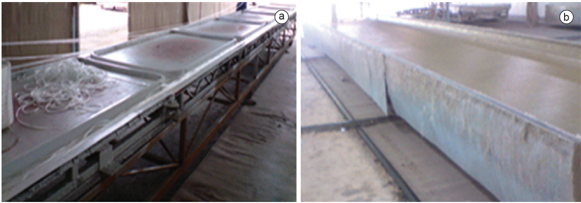
Figura 2. Moldes usados no processo (fevereiro de 2010): a) entrejanelas; b) teto.
