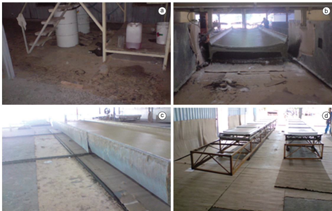
Figura 4. Uso de papelão ondulado no processo de Moldagem e Acabamento em PRFV (fevereiro e maio de 2009): a) piso sob os tambores de resina; b) paredes da laminadora semiautomática e piso sob ela; c) piso em volta e embaixo do molde do teto; d) piso e paredes na laminação das entrejanelas.
