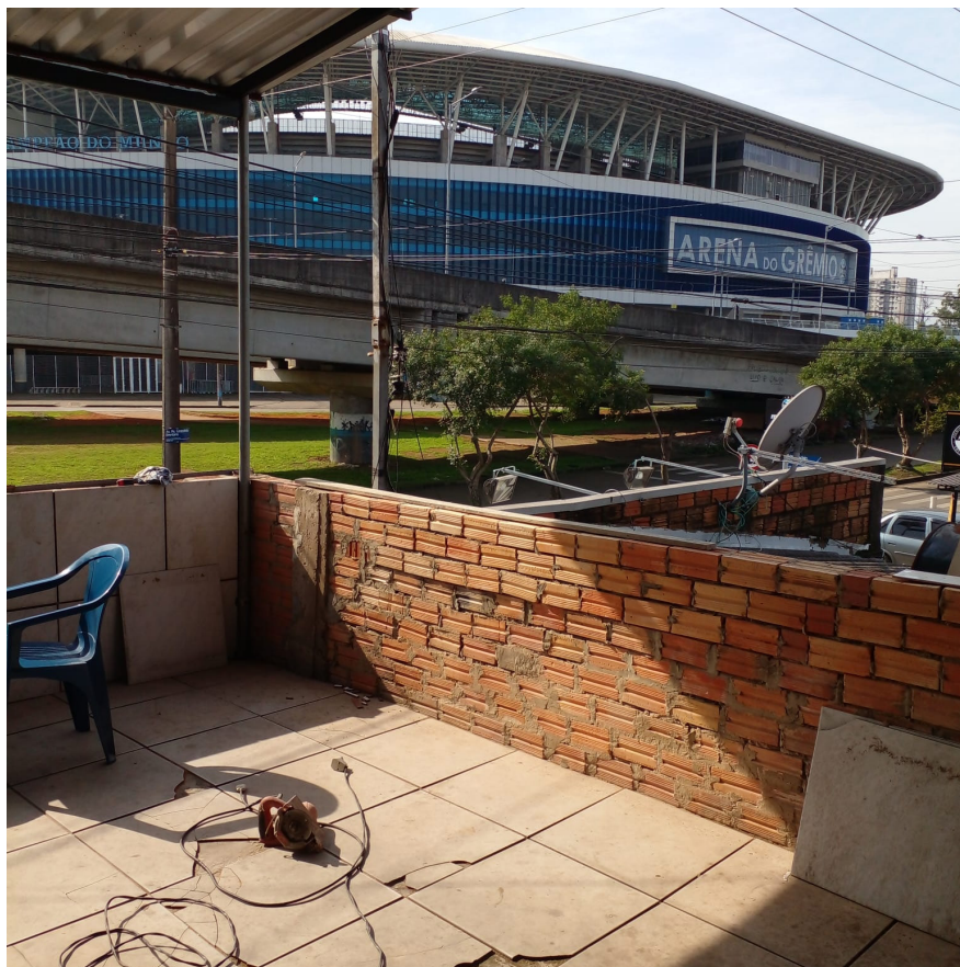
Figura 3. Reformas no segundo piso e vista à Arena do Grêmio em 05/07/2022. Foto do autor.
