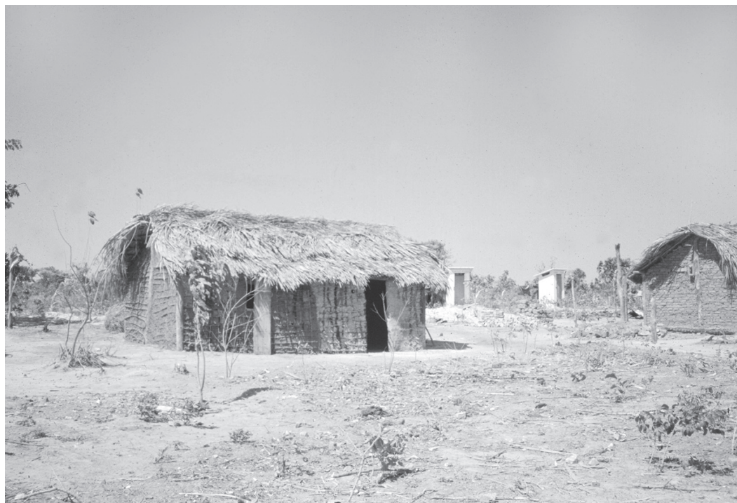
Figura 4: Casa de barro com telhado de sapê e teto de folhas de palmeiras. Realidade encontrada e fotografada por Cynamon em seu trabalho pelo Sesp. Foto apresentada por ele em um dos cursos de formação de inspetores sanitários, s.d. (DSSA/Ensp/Fiocruz)
