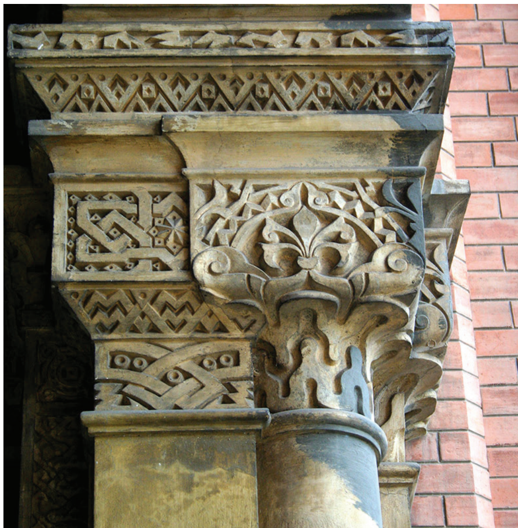
Figura 3: Detalhes dos painéis em estuque e dos tijolos maciços de uma fachada do Pavilhão Mourisco (Foto: Rosio Moyano, 2009; acervo DPH/COC/Fiocruz)
