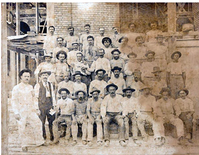
Figura 1: Operários da construção do Pavilhão Mourisco (Foto: J. Pinto; acervo Casa de Oswaldo Cruz/Fiocruz)
