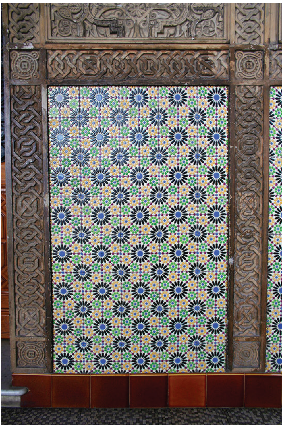
Figura 8: Em tomada das varandas do Pavilhão Mourisco, um painel revestido com azulejos da manufatura Bordallo Pinheiro, contornado por composições em estuque ornamental, e as soluções dadas em cerâmica e pastilhas nos acabamentos do piso (Foto: Rosio Moyano, 2009; acervo DPH/COC/Fiocruz)
