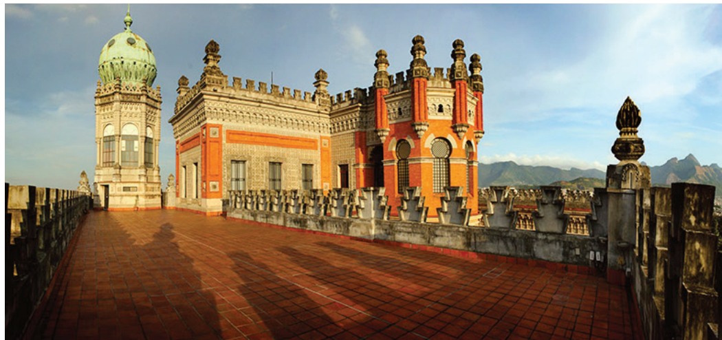
Figura 10: Vista panorâmica do terraço, ala norte do Pavilhão Mourisco (Foto: Rosio Moyano, 2009; acervo DPH/COC/Fiocruz)
