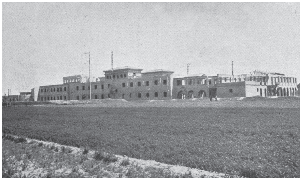
Figura 3: Obras del Hospital Municipal de Infecciosos El Cid, c.1943 (Vidal Jordana, 1946, p.48)
